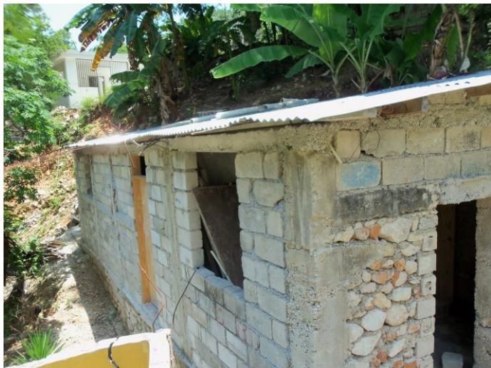
Maison en parpaing chez Kenson
